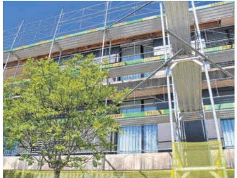
Seit Monaten ist das Wohnheim Schäfliwiese eingerüstet, demnächst sollen die Sanierungsarbeiten beginnen.
